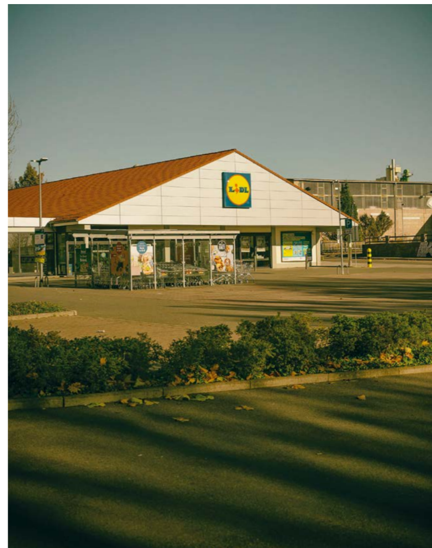
Lidl als Erlösung? Früher stand hier das Gebäude des VEB Spezialkombinats Wasserbau
